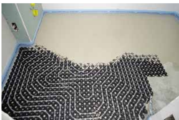
Figura 6.30. Juntas de dilatación.
