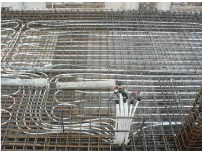
Figura 3.48 Forjados termoactivos. Fuente: Eneres.
