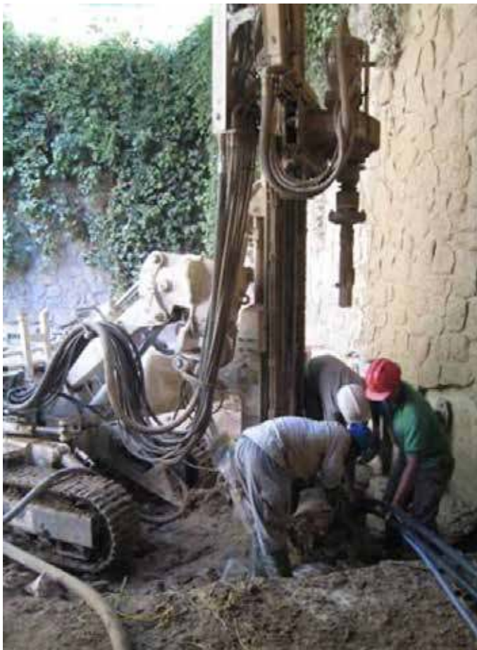
Figura 3.50 Perforación de pozos geotérmicos. Fuente: Eneres.
