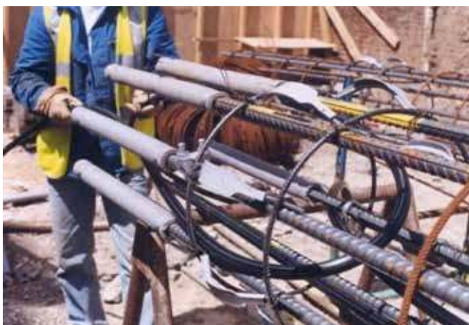
Figura 3.53 Ejecución de pilotes geotérmicos. Fuente: Eneres.
