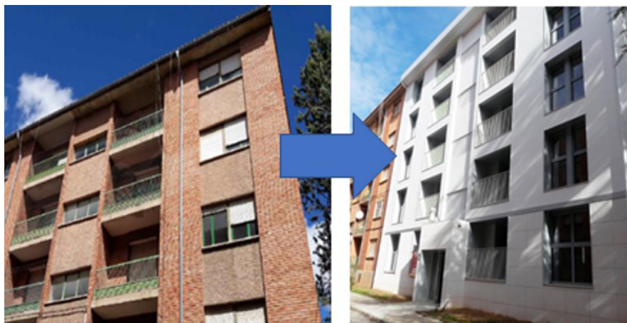
Figura 5.1. Edificio de 10 viviendas en Teruel con rehabilitación integral bajo estándar Passivhaus. Fuente: Dirección General de Vivienda de Aragón
