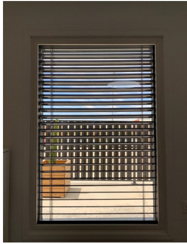
Figura 15. Protecciones solares. Vivienda en Carrión de los Condes (Fuente: Medgón PassivHaus)
