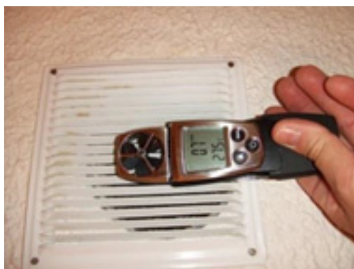
Figura 5. Medición con anemómetro en rejillas de ventilación (Fuente: Luis Jiménez López)
